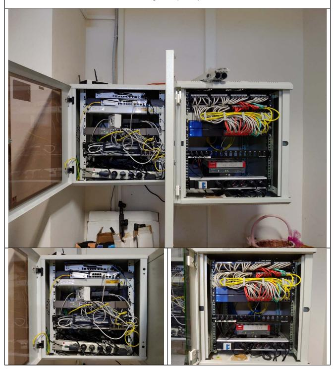
Al piano primo si prevede l'adeguamento di n. 15 punti presa dati esistenti con relativo cablaggio e accessori di categoria Cat6 nei punti indicati sulla piantina con il simbolo P (compresi AP) oltre ai 17 punti presa presenti nel laboratorio di informatica; la fornitura di 2 nuovi punti presa Cat6 con relativo cablaggio per le aule indicati in piantina con il simbolo +P; l'adeguamento/fornitura dei 4 Patch Panel presenti negli armadi rack con opportuni di
