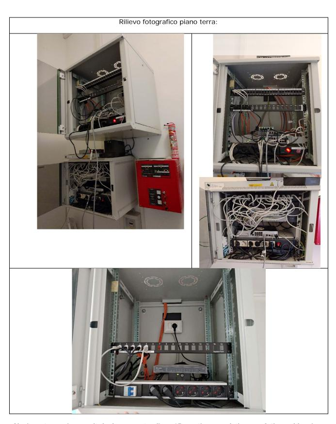
Al piano terra si prevede l'adeguamento di n. 15 punti presa dati con relativo cablaggio e accessori di categoria Cat6 nei punti indicati sulla piantina con il simbolo P e AP; la fornitura di
